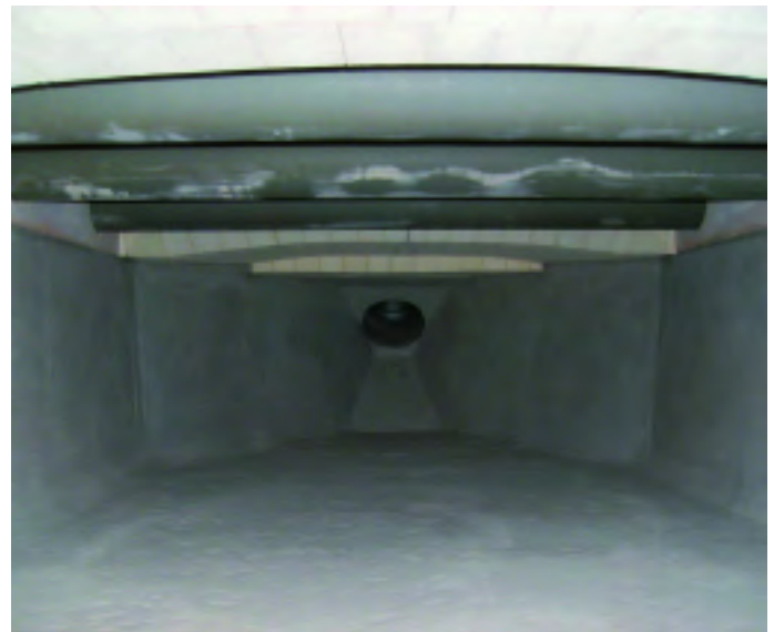
El sofisticado concepto de revestimiento de los hornos de dosificación Westomat evita los costosos y prolongados trabajos adicionales.
