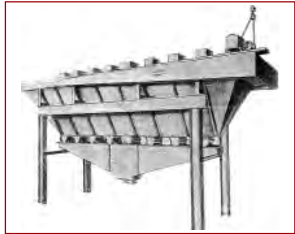
Figura 5. Hidro-clasificador del tipo horizontal tipo Mac Lanahan.
