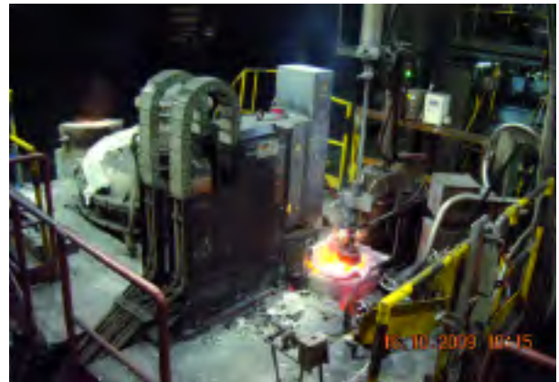
Fig. 1. Instalación del sistema de calentamiento por plasma térmico de alta potencia.
