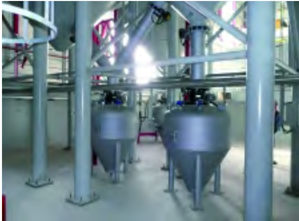
Abastecimiento de arena neumático con transportadores de empuje FAT.
