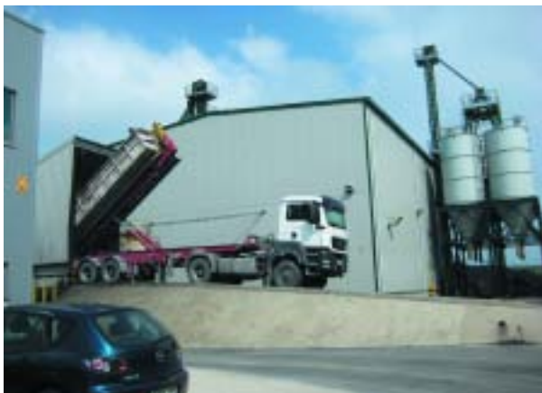
Figura 2. Zona de descarga de camiones.
