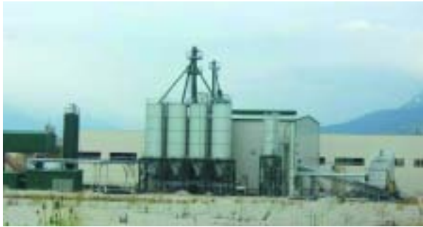
Figura 1. Vista general de la planta.
