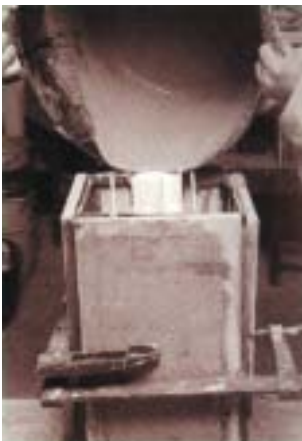
Figura 10. Moldeo horneado.
