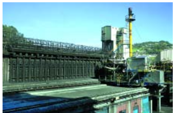
Figura 16. Vista de la batería de coque.
