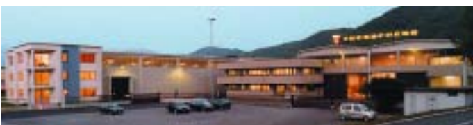
Fábrica de Tecnopress de Monticelli Brusati.
